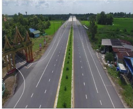
เสาไฟฟ้า
